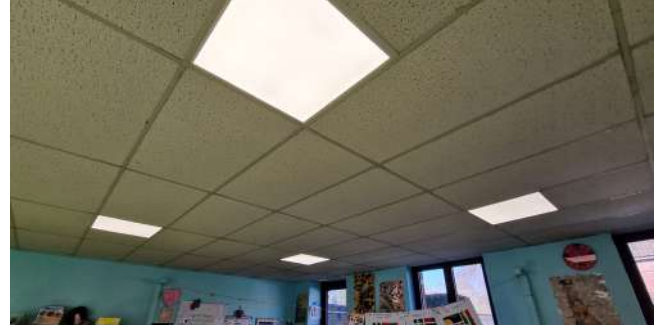
Installation de dalles lumineuses par les agents du service technique, dans 3 classes de l'école Suzanne Lanoy. Coût : 565.92€
